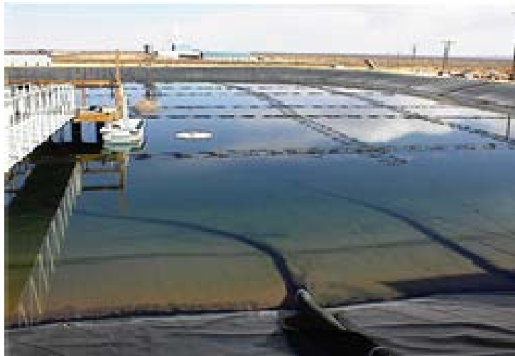
Illustration 1. Etang solaire expérimental (Source Université d'El Paso).
