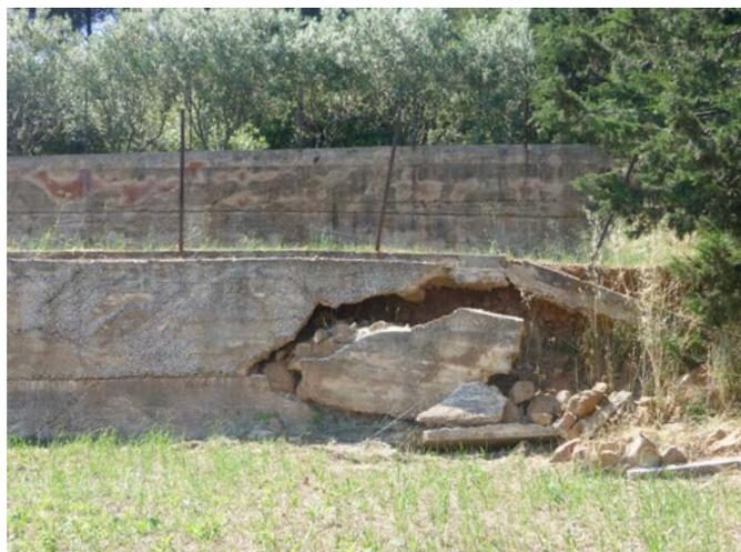
Effondrement d'un mur en pierre sèche recouvert d'enduit
